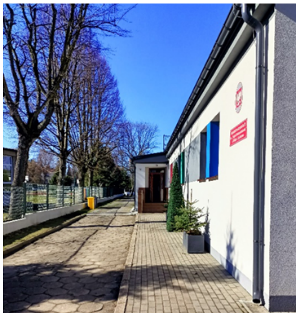
Zdjęcie przedstawia budynek przedszkola
